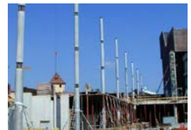
FAU Erlangen-Nürnberg: Einteilige Stützen mit 16 m Länge
