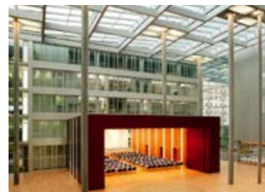
Haus der Ärzteschaft Düsseldorf: Gesamte Dachentwässerung innenliegend
