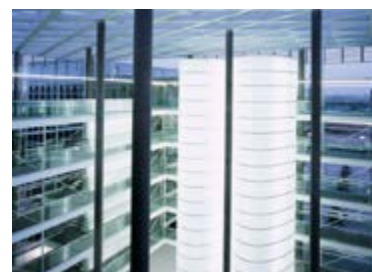
VHV Versicherungen Hannover: Stützen mit 25 m Länge und Ø 0,45 m
